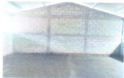
Foto 5: Se observa con una fundición de piso liso de cemento del módulo.
