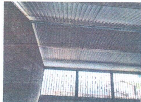
Foto 2: Se observa instalada las costaneras del módulo.
