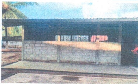
Foto 5: Se observa instalada la puerta del módulo.
